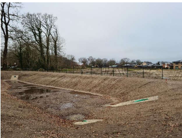
Regenrückhaltebecken Holzfeld in Fredenbeck
