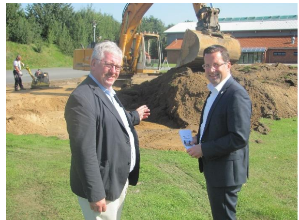
Frank Havemann und Kai Seefried bei den ersten Erdbauarbeiten für das neue Jugendhaus
